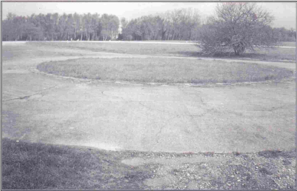
▲ Près de Kervaise, les JU 88 utilisaient pour les compensations de leurs compas, une "table" pivotante en bois. La fosse ayant été comblée, seul, un grand disque de gazon témoigne encore de l'existence de ce curieux "manège".
