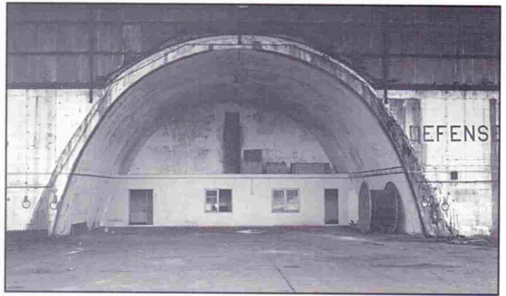
▲ Ce qui subsiste d'un des 17 hangars construits par l'entreprise HOLZMAN dans le secteur KEREMBAR-S-TREMERZIN. Une seconde arche en béton, beaucoup plus grande précédait celle que l'on aperçoit. Il n'en reste plus une seule...
