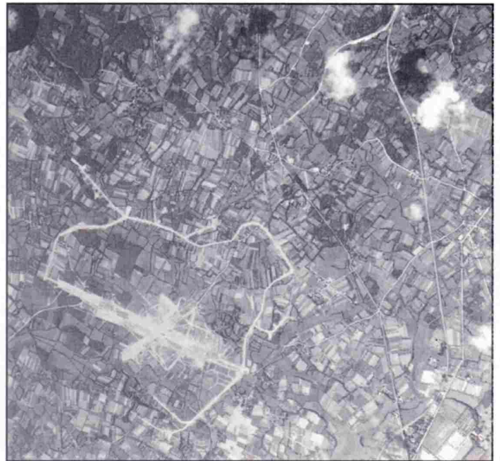
▲ Le 18/08/1941 - La piste Est-Ouest et les chemins de roulement de la partie Nord et du secteur de KERMADEHOY sont achevés. La construction de la Nord-Sud est à peine entamée.
